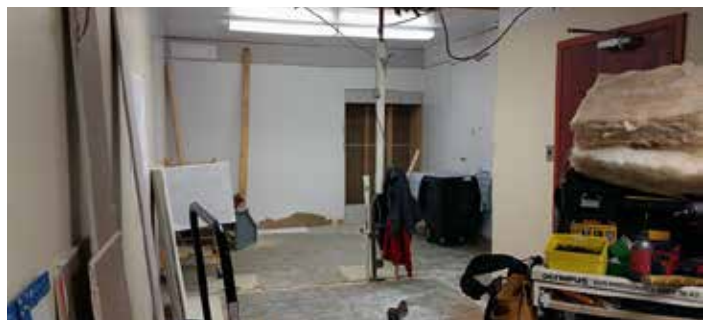
La future salle de chirurgie mineure où les travaux vont bon train!
